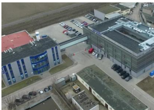
Obraz 5: nowa fabryka (Etap I inwestycji)
